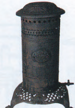
図13 米国製バルカンストーブ/大正元年 鉄板を丸めた円筒の内部でガスの炎を燃やし、室内を暖房するストーブ。製造したメーカー名より、同型のストーブを「バルカンストーブ」とも総称された
