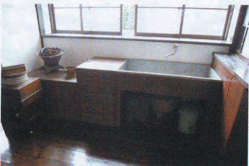
図27 江戸東京たてもの園にある常盤台写真 場のブリキを張ったシンク
